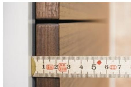
3. Таким образом можно оптимально отрегулировать зазоры между фасадами.
